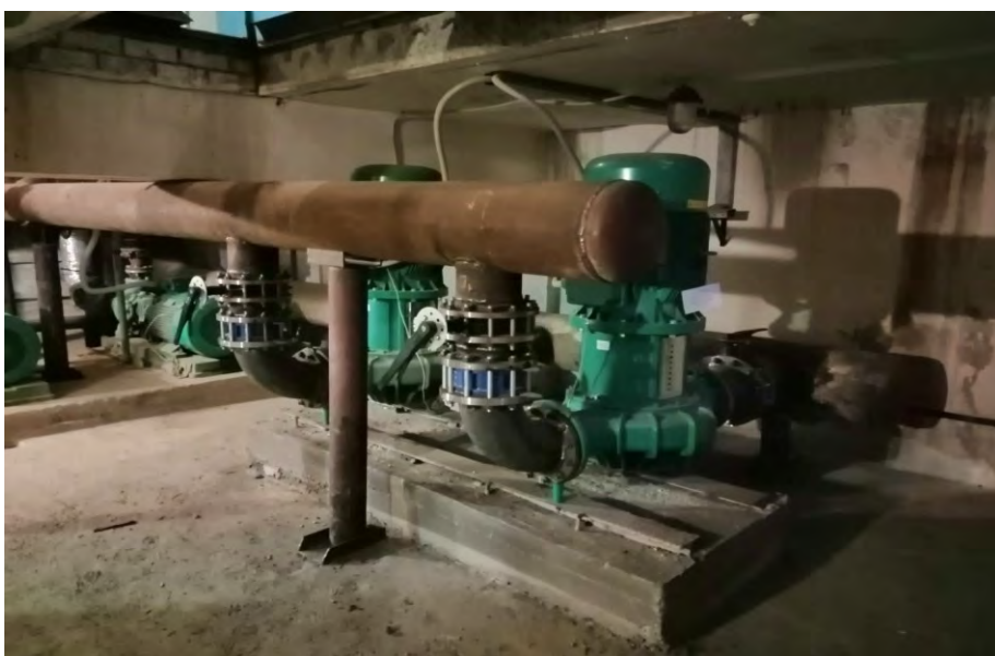
Рисунок 7.54: Сетевые насосы ЦТП-5
