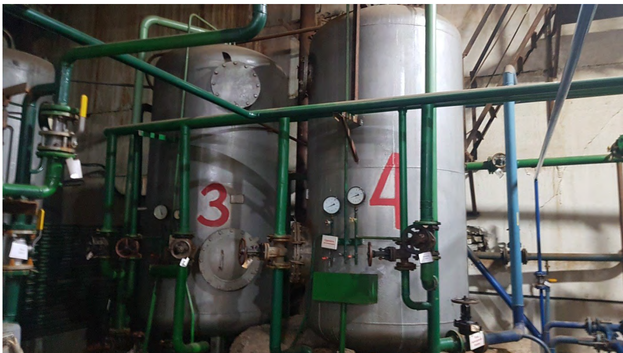
Рисунок 7.30 Оборудование химводоподготовки
