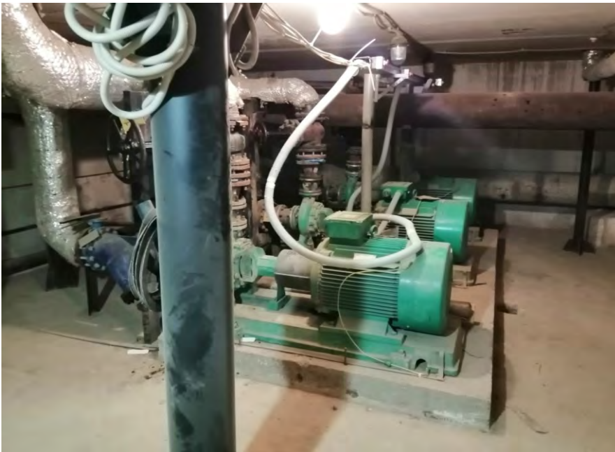
Рисунок 7.51: Сетевые насосы ЦТП-5
