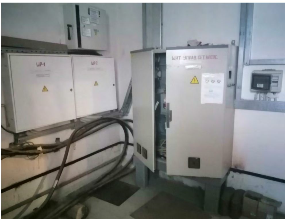
Рисунок 7.56: Электрощитовая ЦТП-5
