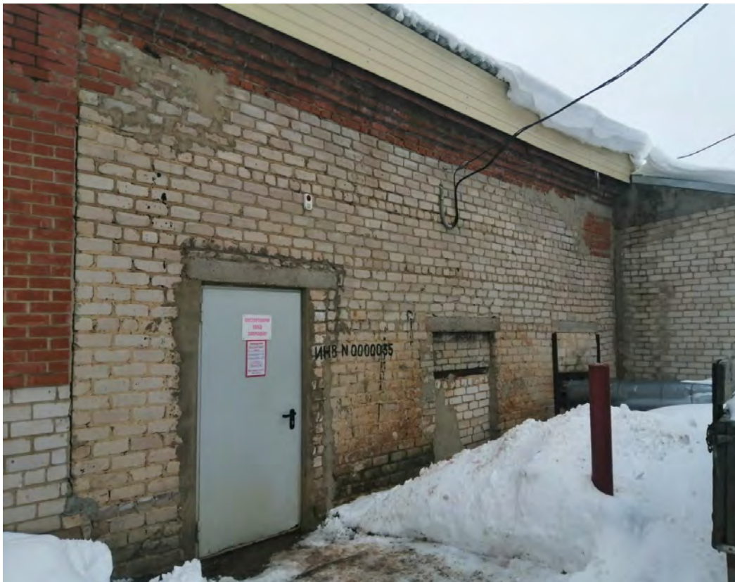
Рисунок 7.68: Фасад здание ЦТП-4
