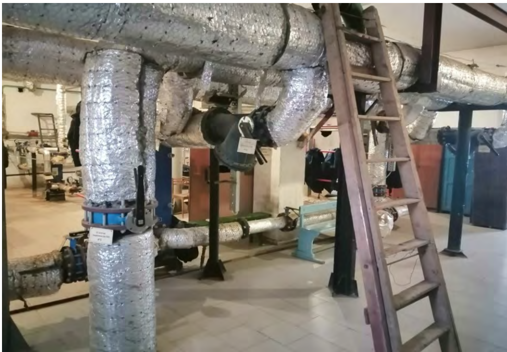
Рисунок 7.57: Обвязка теплообменного оборудования ЦТП-5
