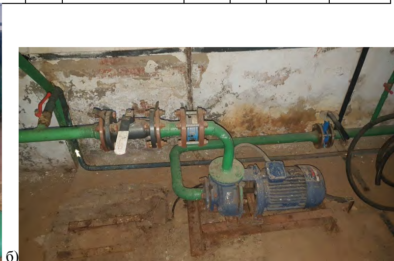
Рисунок 7.36: а - сетевые насосы WILO100/170-30/2; б - подпиточный насос К-65-50-160
