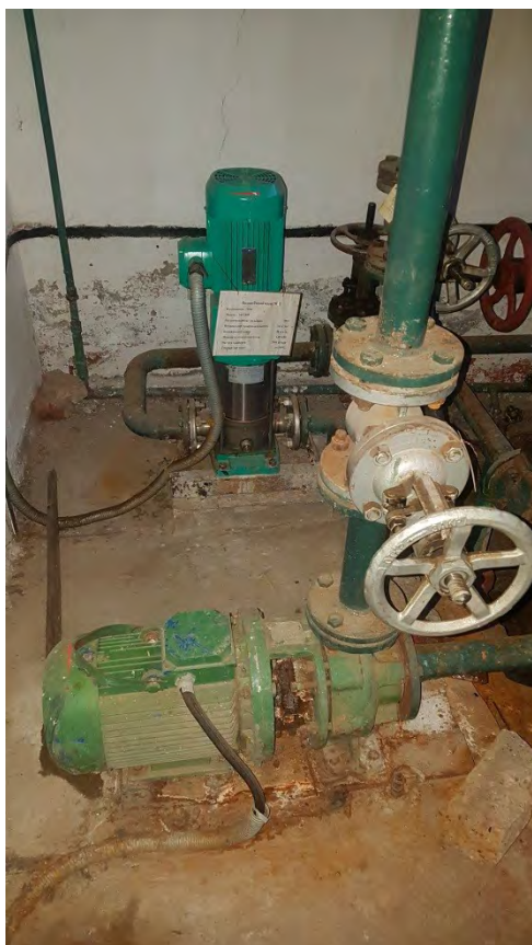
Рисунок 7.31 Состояние насоса К65-50
