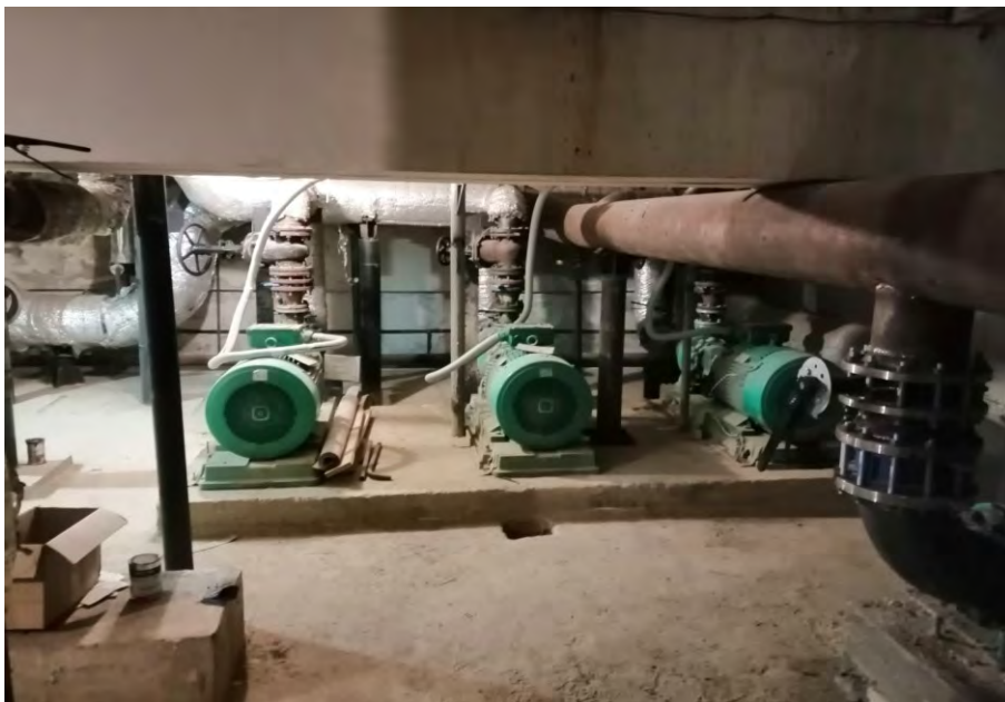
Рисунок 7.53: Сетевые насосы ЦТП-5
