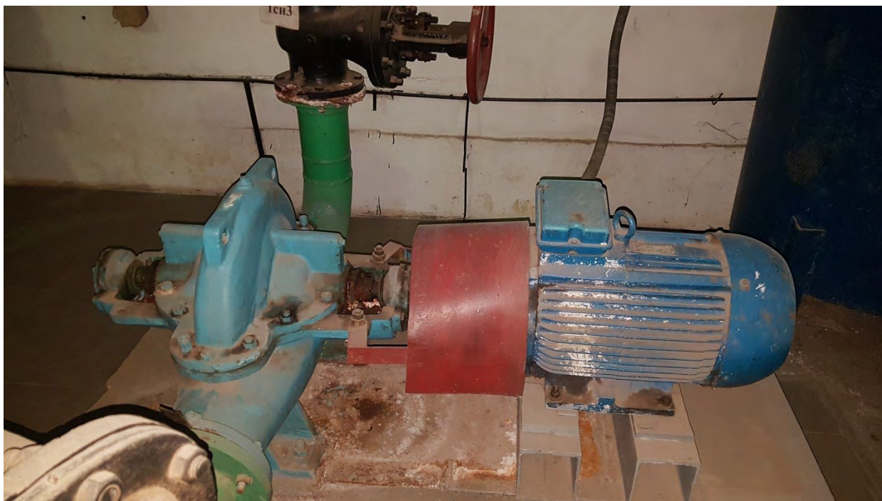
Рисунок 7.35 Сетевой насос Д-200-36
