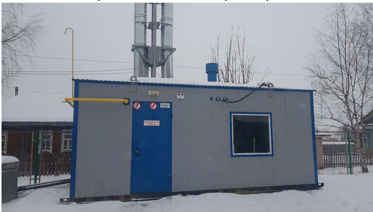
Рисунок 7.47: Блочно-модульная котельная.
