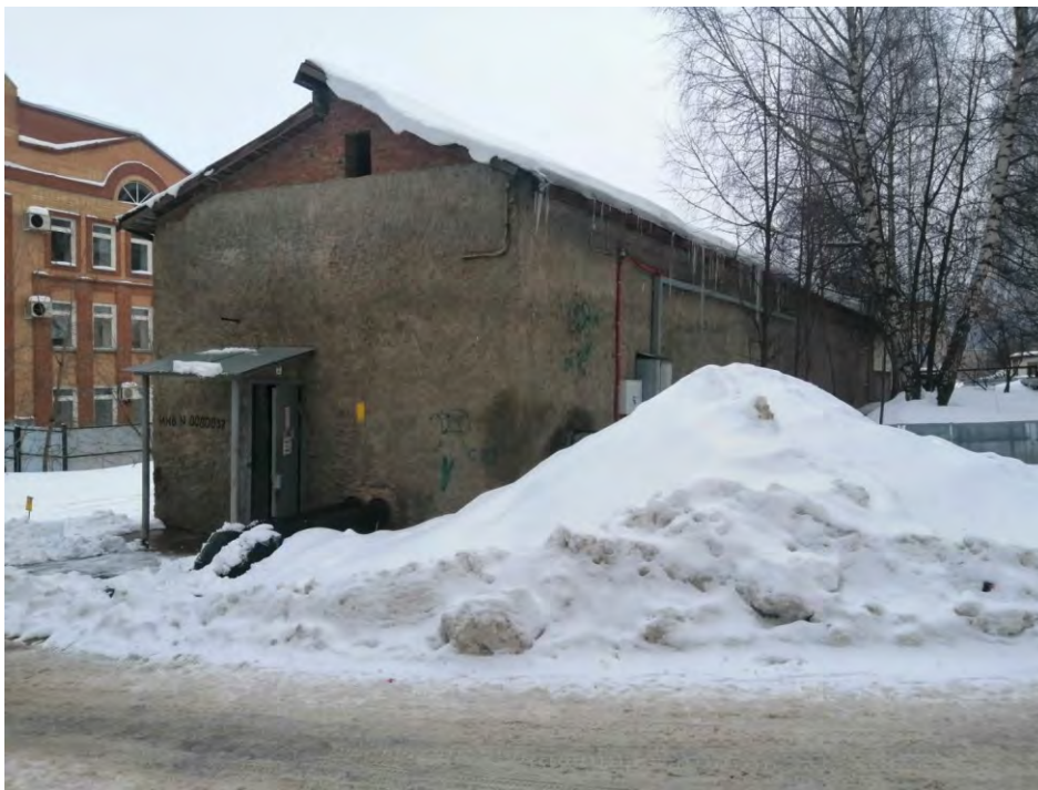
Рисунок 7.73: Фасад здание ЦТП-2
