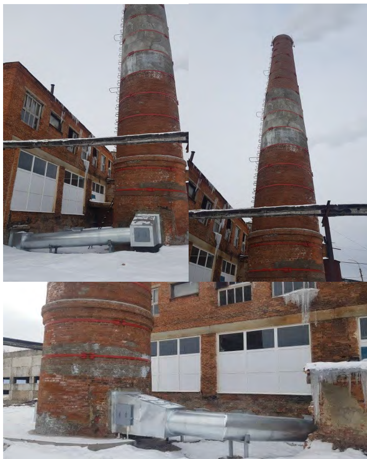
Рисунок 7.27 – Дымовая труба, H=30 метров и металлические газоходы после ремонта.
