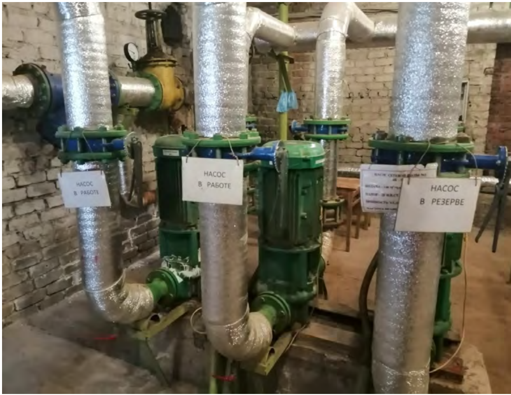
Рисунок 7.67: Сетевые насосы ЦТП-4
