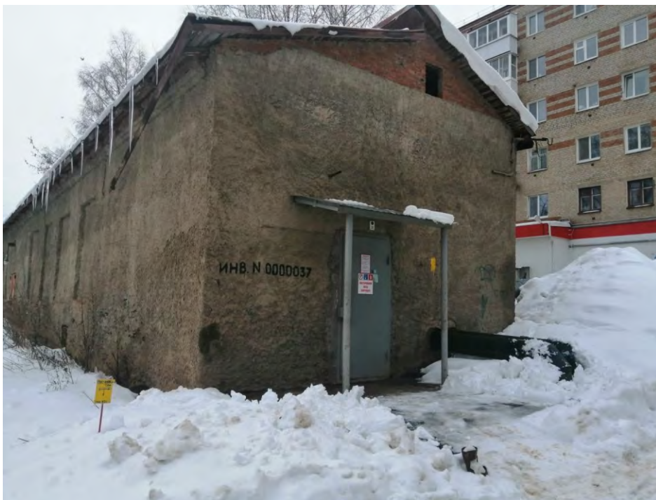
Рисунок 7.74: Фасад здание ЦТП-2
