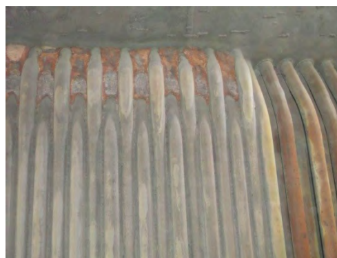
Рисунок 7.10 Состояние труб конвективной части котла ДЕ-10 г №1: Глубокая наружная коррозия металла в местах стыков труб с верхним и нижним барабаном котла.
