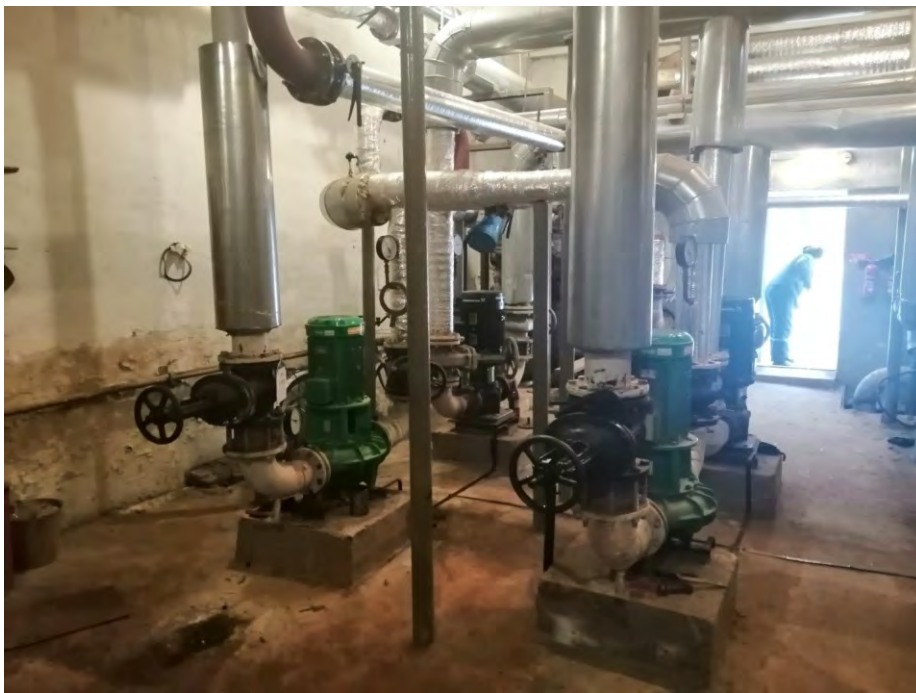
Рисунок 7.76: Сетевые насосы ЦТП-2
