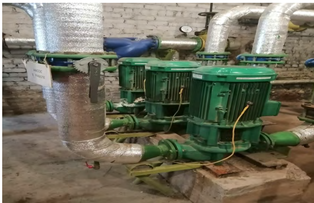
Рисунок 7.64: Сетевые насосы ЦТП-4
