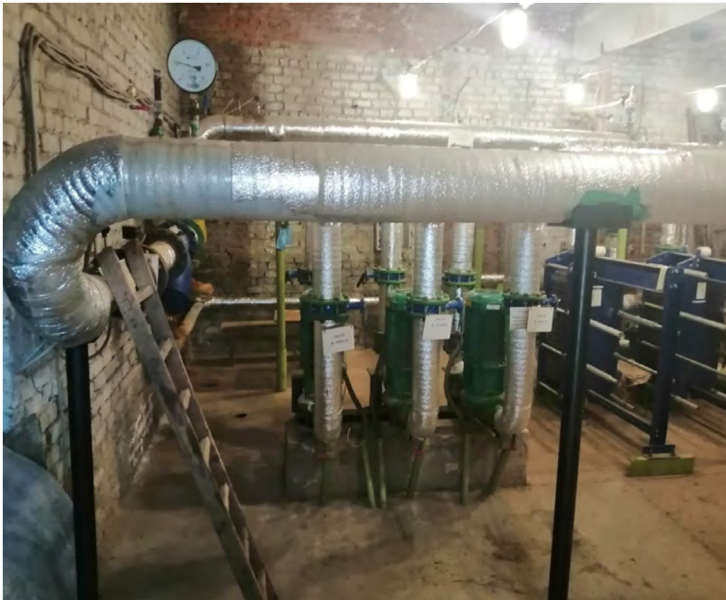
Рисунок 7.69: Сетевые насосы ЦТП-4
