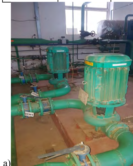
Рисунок 7.36: а - сетевые насосы WILO100/170-30/2; б - подпиточный насос К-65-50-160
