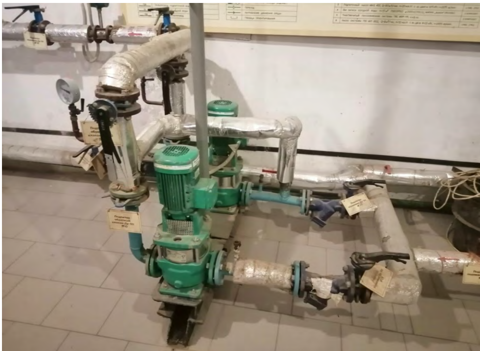
Рисунок 7.59: ЦТП-5 насосы для нужд физкультурно-оздоровительный комплекс «Плавательный бассейн».
