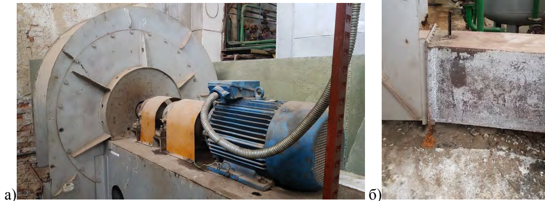
Рисунок 7.29 дымосос №3 -(а), дымоход котла №1-(б).
